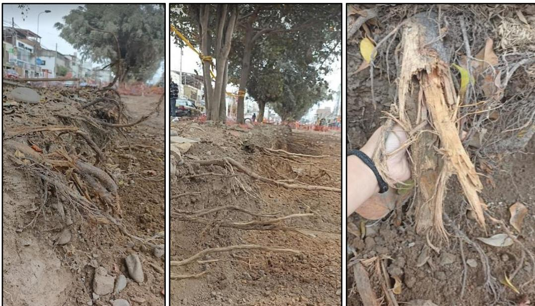
**Figura N° 28.** Afectación a la estructura radicular de anclaje del arbolado próximo a la construcción de una ciclo vía; asimismo, se evidencia problemas de degradación del suelo del área de intervención.
