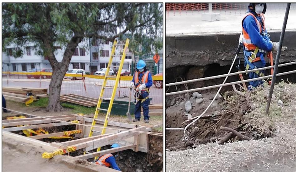
**Figura N° 27.** Ejecución de inadecuadas podas radiculares en las raíces de anclaje de un individuo arbóreo de la especie *Schinus molle* “Molle serrano”, con herramientas inapropiadas (barreta) y sin desinfección. Dicha práctica tiene un impacto negativo en el estado de conservación (infección por patógenos) y estabilidad (riesgo de caída) del árbol.
