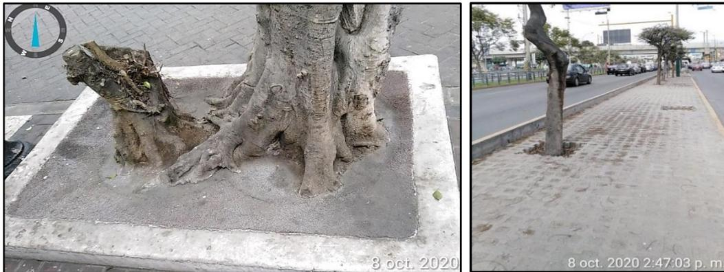
**Figura N° 25.** Problemas de cimentación en la superficie del suelo, lo cual afecta indirectamente al sistema radicular de las especies vegetales próximas y ocasiona la pérdida de área verde.
