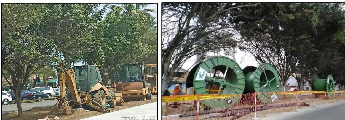
**Figura N° 23:** Uso de maquinaria pesada y acumulación de materiales de construcción sobre la superficie del área verde.
