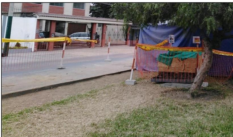
**Figura N° 24.** Compactación de suelo, marchitamiento del césped y afectación al sistema radicular de un árbol de *Schinus molle* “Molle serrano”; debido al uso de maquinaria pesada y tránsito frecuente del personal operario en las áreas verdes.
