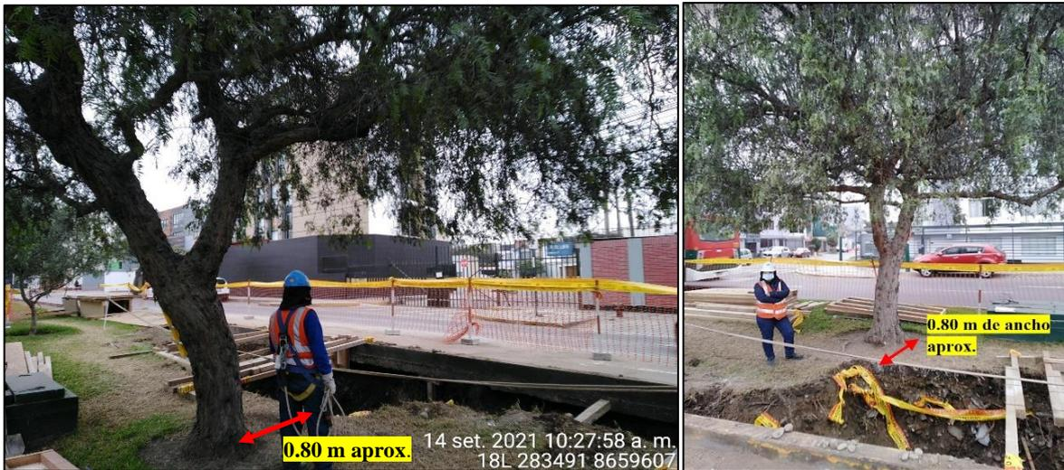
**Figura N° 56.** Apertura de una zanja (1.80 m aprox. de ancho y 2.00 m aprox. de profundidad) para instalación del servicio eléctrico, situada a una distancia aproximada de 0.80 m de un individuo arbóreo de la especie *Schinus molle* “Molle serrano”, el cual presenta un impacto negativo en el sistema radicular arbóreo. Además, el área verde presenta problemas de pérdida de cobertura vegetal de la especie *Stenotaphrum secundatum* “Gras americano” y la estructura del suelo.
