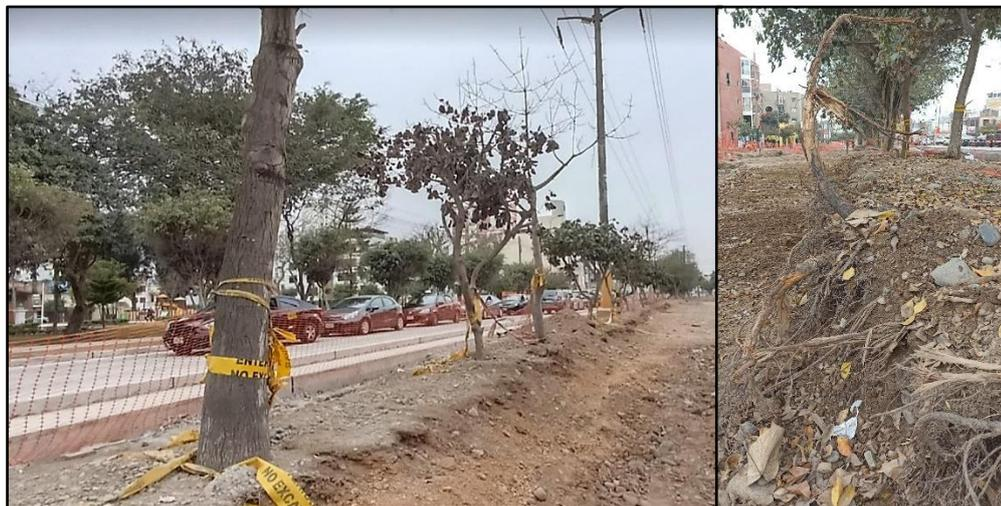
**Figura N° 31.** Disminución del nivel o cota del suelo, el cual involucra una poda radicular severa en el arbolado, ocasionando problemas de estrés hídrico y pérdida de estabilidad de los árboles por la pérdida de raíces de anclaje.
