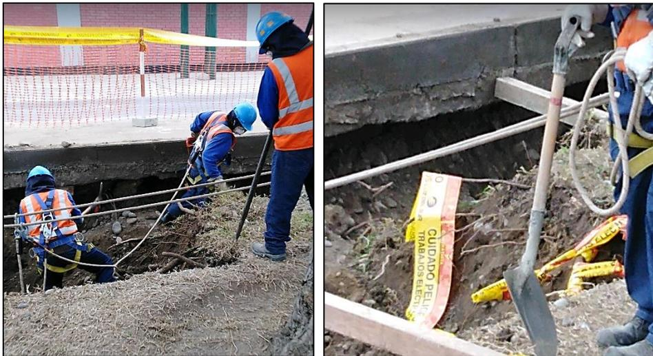
**Figura N° 57.** Ejecución de inadecuadas podas radiculares en las raíces de anclaje de un individuo arbóreo de la especie *Schinus molle* “Molle serrano”, con herramientas inapropiadas (pala y barreta) y sin desinfección, evidenciándose el uso de cintas de seguridad para envoltura de algunas raíces. Dicha práctica tiene un impacto negativo en el estado de conservación (infección por patógenos) y estabilidad del árbol (riesgo de caída).
