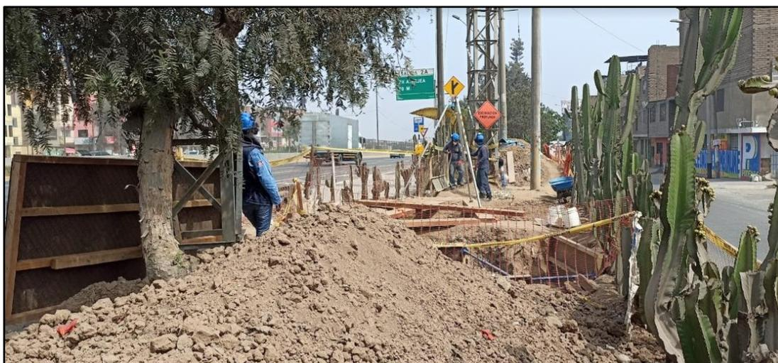
**Figura N° 29.** Acumulación de residuos sólidos provenientes de excavaciones sobre la base del fuste de un árbol de la especie *Schinus molle* “Molle serrano” y varias suculentas arbustivas de la especie *Euphorbia candelabrum* “Candelabro”; los cuales presentan un limitado intercambio gaseoso y mínimo drenaje en el sistema radicular. Además, dicha práctica también causa compactación en la superficie del suelo.
