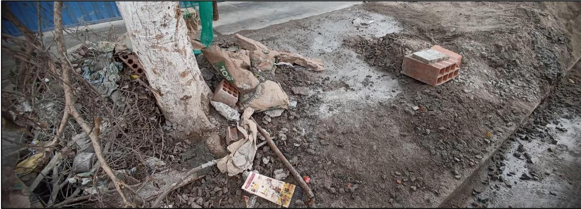
**Figura N° 13.** Materiales de origen antrópico (restos de ladrillos, cemento, piedra chancada, arena gruesa, residuos sólidos, etc.) y recubrimiento de concreto y hormigón sobre el suelo urbano situado en una berma lateral, en el distrito de Breña.
