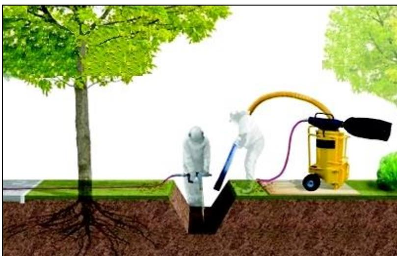
**Figura N° 51.** Ejecución de Zanjas subterráneas mediante tecnología de excavación aérea o sin contacto, llamada “Pala de Aire” (Fuente: AirSpade, 2021).
