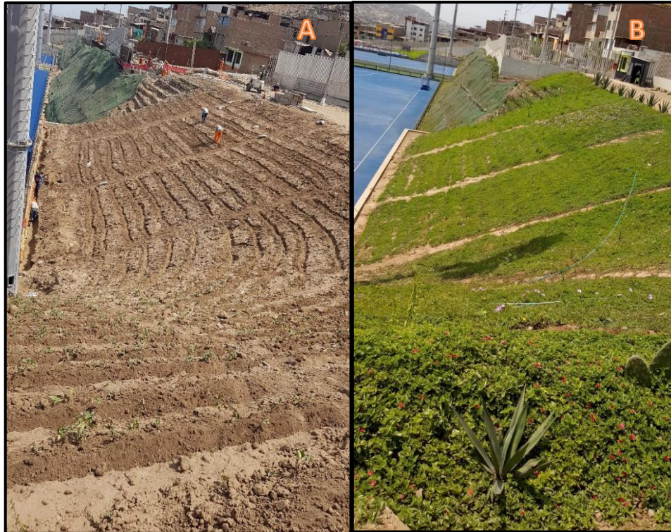
Figura 17: Comparación del antes y después de la instalación de individuos de la especie Aptenia cordifolia en la zona de talud
