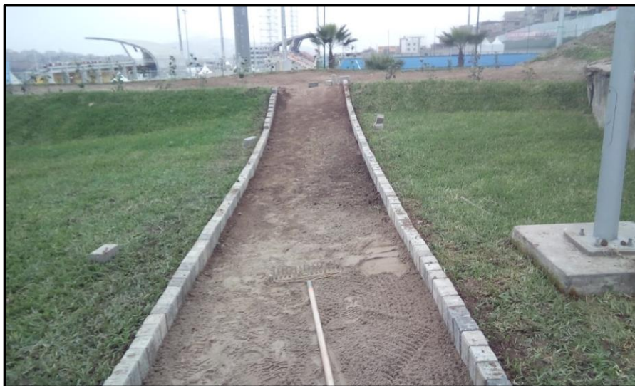
Figura 12: Césped instalado y creación de camino hacia zona del mirador
