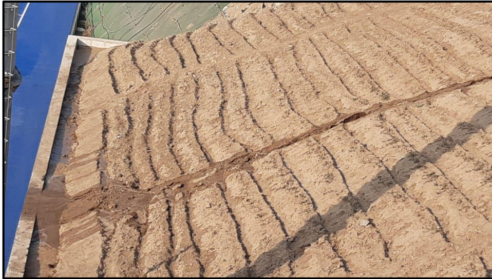
Figura 9: Drenaje de agua de riego y lavado de tierra en zona de talud
