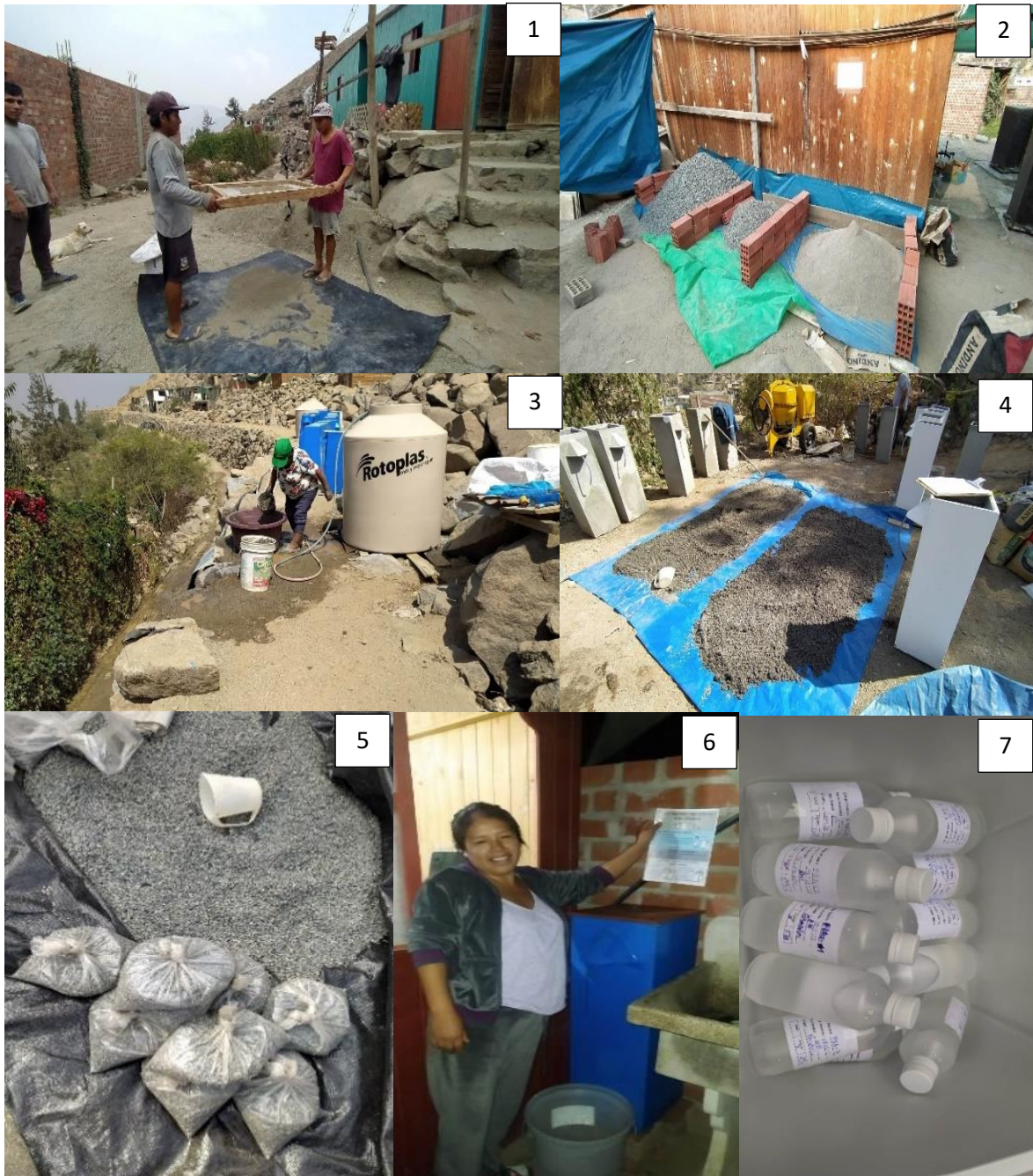
Figura 59: Tamizado del medio filtrante
