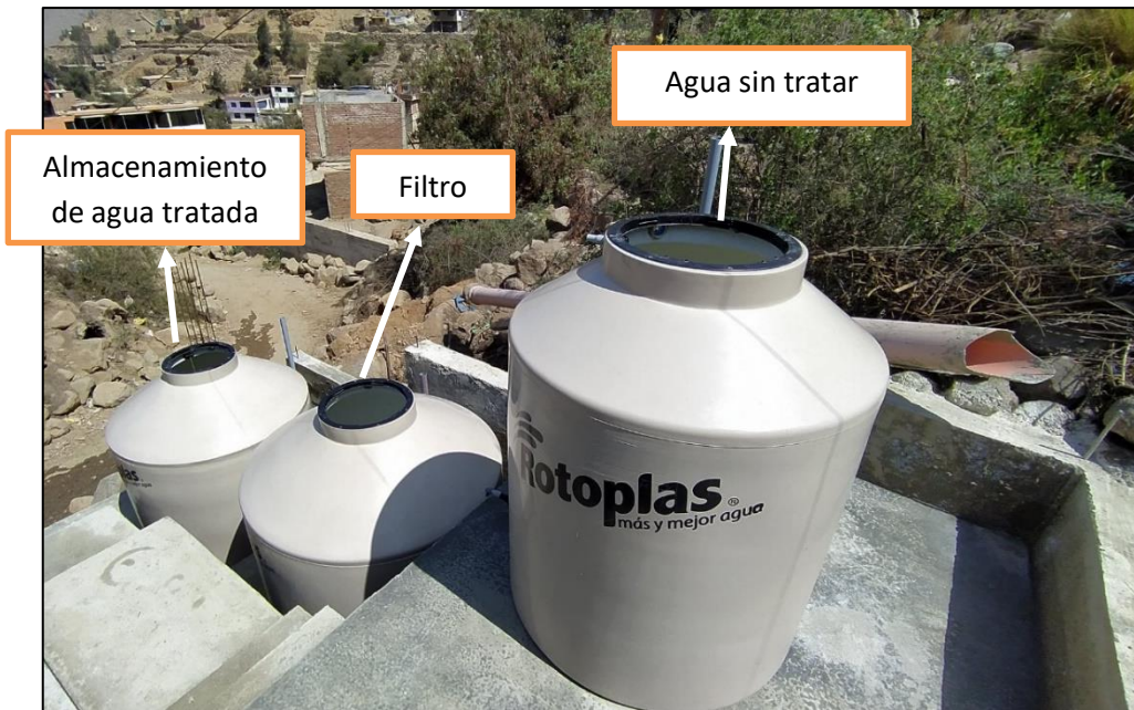
Figura 30: Diagrama del Filtro Lento de Arena Intermitente (FLAI)
