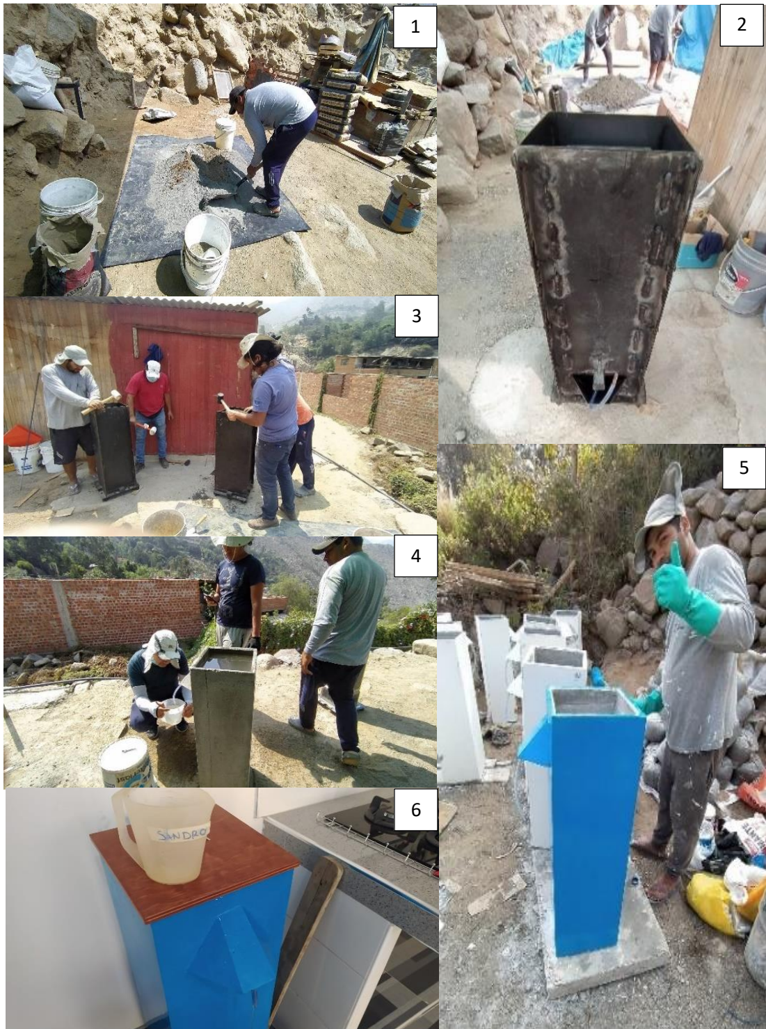
Figura 58: Pasos para la elaboración de FBA
