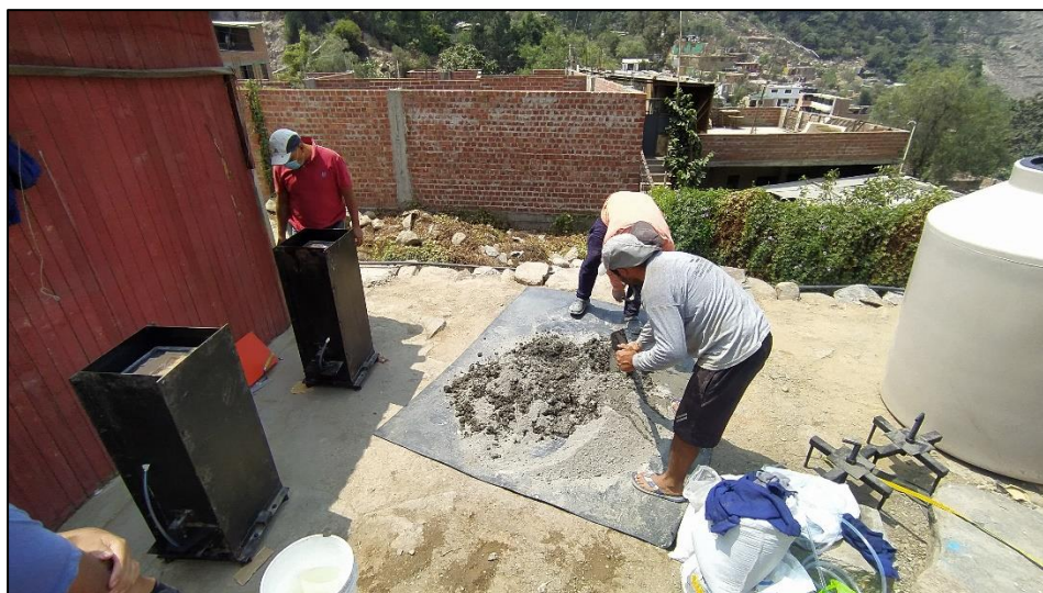
Figura 24: Preparación del concreto 210 kg/cm 2
