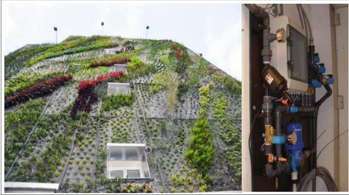
Figura 1. Patrick Blanc, Jardín Vertical en París (Calles Aboukir y the Petits Carreaux) y Sistema de Control Automático, Edificio Ford en Amsterdam (Middelle)
