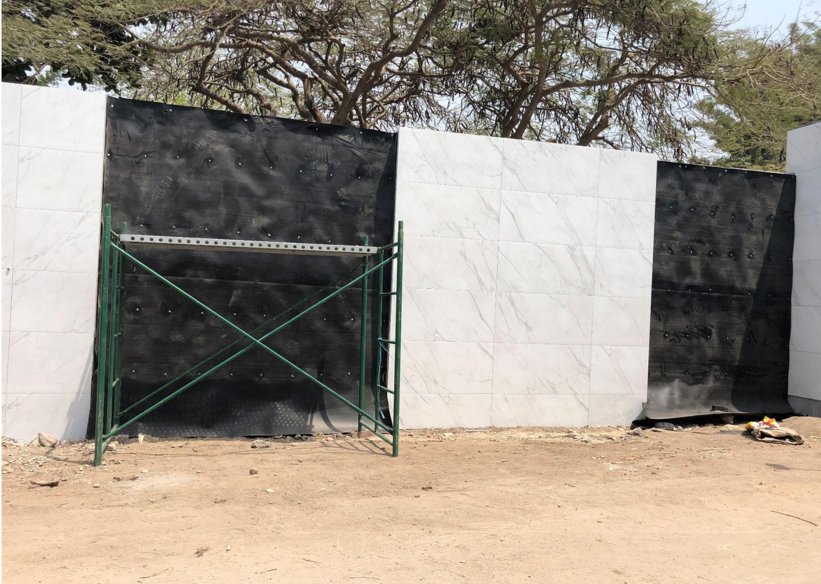
Anexo 5 Atornillado de geomembrana HDPE 1mm
