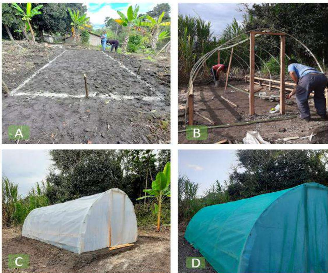
a) Nivelación y marcado de terreno, b) Estructura, c) Instalación de plástico transparente, d) Instalación de malla rachell.
