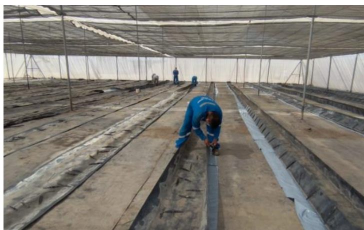
Figura 13: Tendido e instalación de canaletas en casa malla
