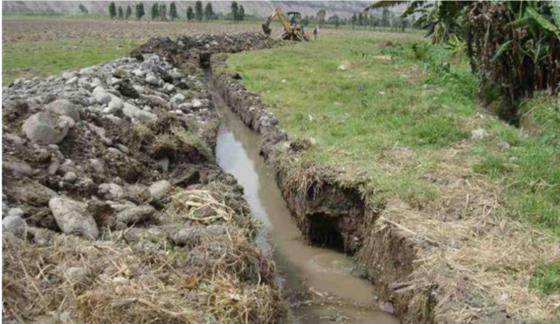
Figura 46: Construcción de drenes
