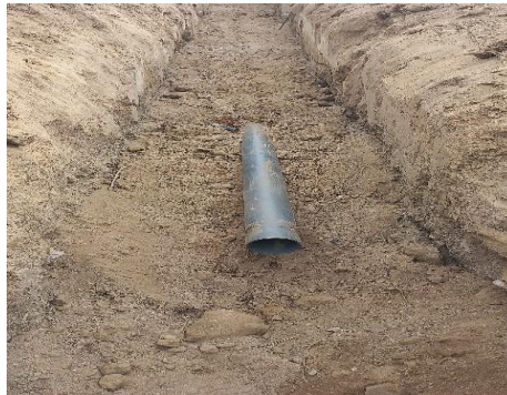
Figura 16: Relleno con material propio
