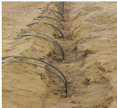
Figura 26: Relleno con material propio
