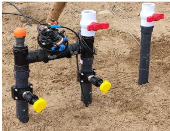
Figura 31: Instalación de arco de servicios
