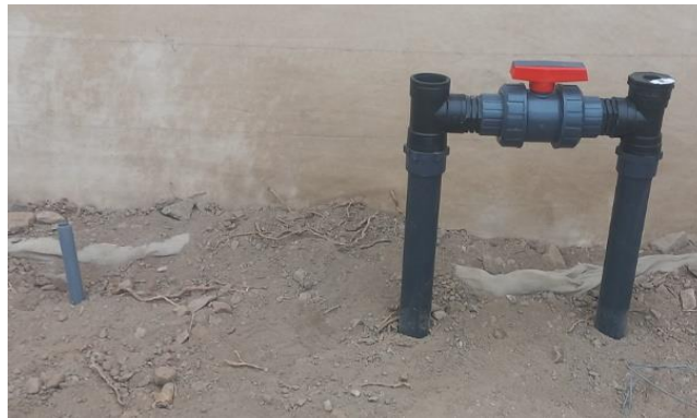
Figura 37: Instalación de arco de riego de camino
