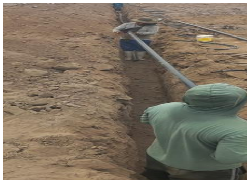
Figura 21: Instalación de tubería terciaria
