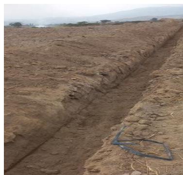
Figura 10: Perfilar y rastrillar zanja
