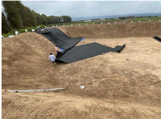
Figura 41: Revestimiento con geotextil
