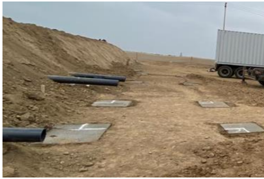
Figura 49: Vaciado de dados de concreto
