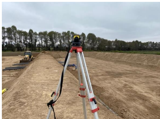
Figura 40: Verificación del movimiento de tierra
