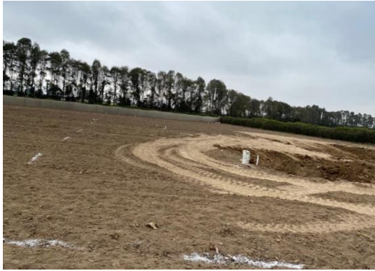
Figura 38: Replanteo del reservorio
