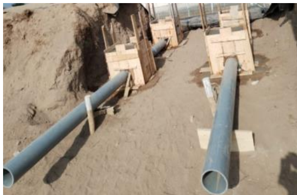
Figura 43: Instalación de tubería de succión
