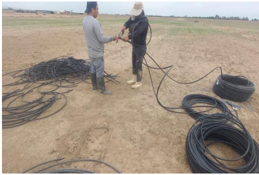
Figura 22: Preparación de bigotes
