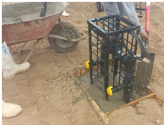
Figura 32: Vaciado de base y tarrajeo
