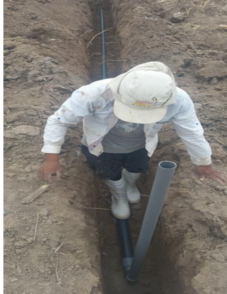
Figura 28: Instalación de ganso de la tubería terciaria
