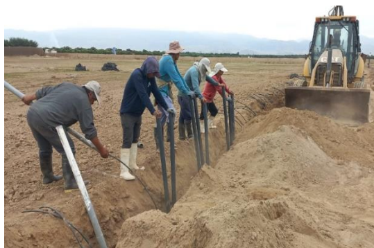
Figura 27: Movimiento de tierra con maquinaria
