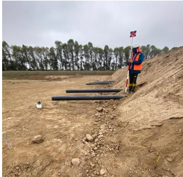
Figura 44: Verificación de cotas de la tubería
