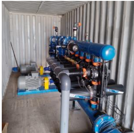
Figura 52: Montaje de piping
