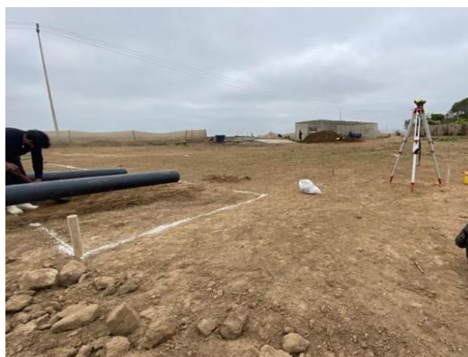
Figura 48: Replanteo de contenedores
