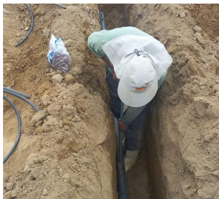
Figura 24: Inserción de conectores iniciales
