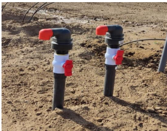
Figura 35: Instalación de válvula de aire
