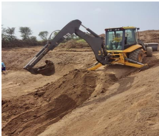
Figura 39: Movimiento de tierra del reservorio
