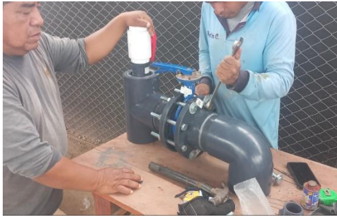
Figura 33: Ensamblaje de válvula de paso
