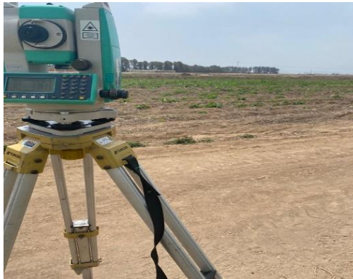
Figura 6: Replanteo con estación total
