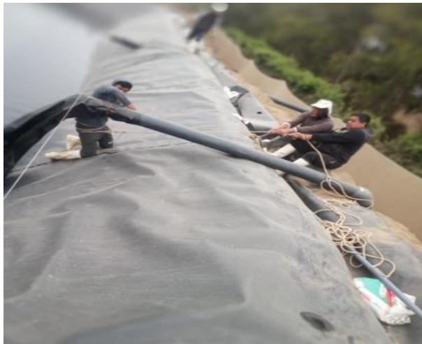
Figura 45: Instalación de tubería de descarga
