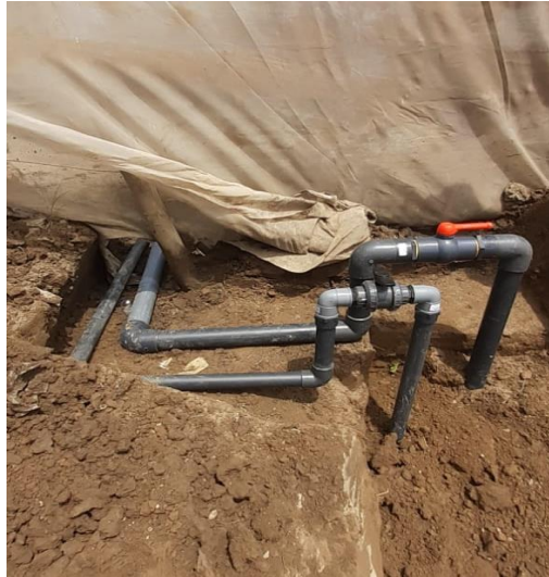
Figura 36: Instalación de despiche 3" y 2"
