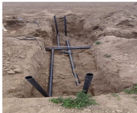
Figura 18: Instalación de aguas arriba arco riego agrícola y de servicios
