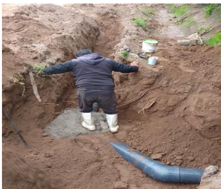
Figura 15: Vaciado de dado concreto
