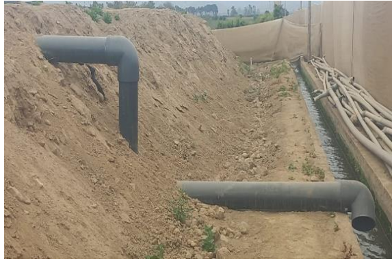
Figura 46: Instalación de tubería de rebose
