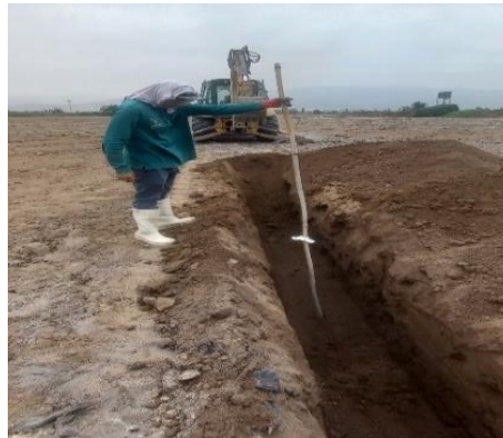
Figura 9: Excavación y monitoreo de maquinaria
