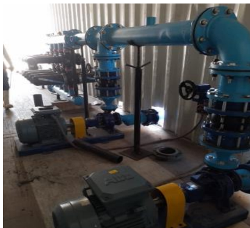
Figura 51: Montaje de electrobombas
