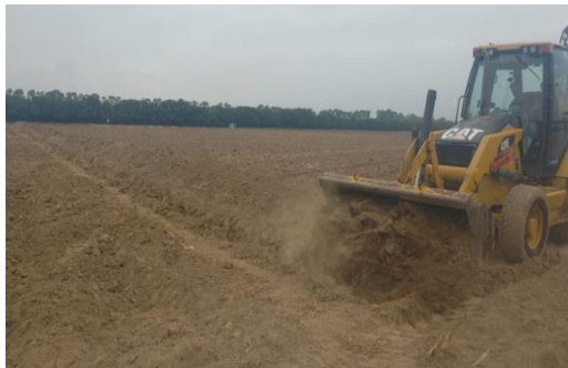
Figura 20: Tapado de zanja con maquinaria
