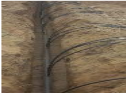
Figura 25: Instalación manguera de 16mm
