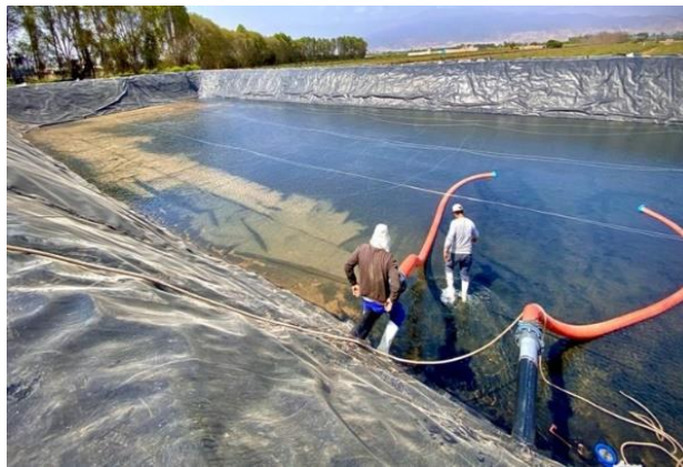
Figura 47: Instalación de mangueras alambradas
