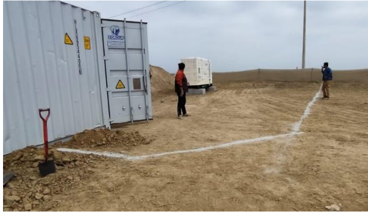
Figura 54. Replanteo y conexión de la red con el cabezal de filtrado
