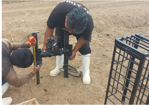
Figura 30: Instalación de arco agrícola
