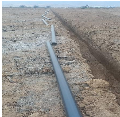
Figura 12: Limpieza y alineación de tubos
