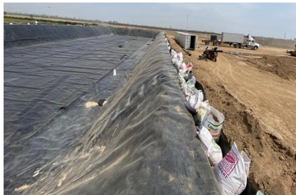
Figura 42: Revestimiento con geomembrana
