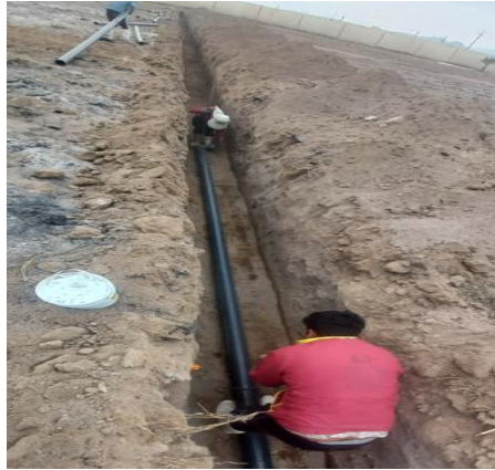
Figura 13: Instalación de tubería agrícola
