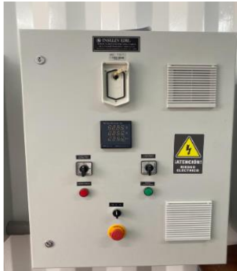
Figura 53: Montaje de tableros eléctricos
