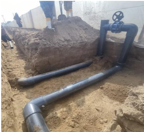
Figura 34: Instalación de válvula de paso
