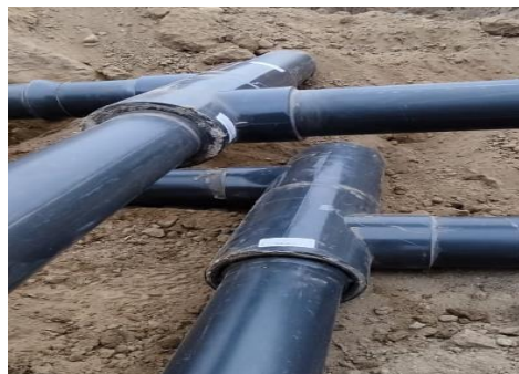
Figura 17: Instalación de tubería de servicios
