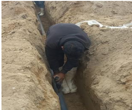
Figura 23: Perforación de 16mm tubería terciaria
