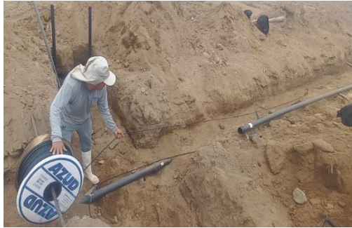
Figura 19: Tendido de manguera 8 mm
