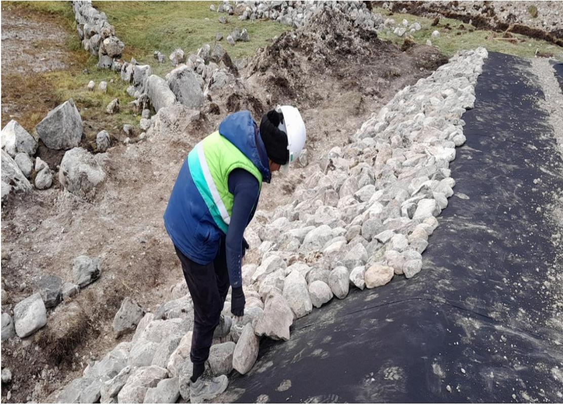
**Figura 40: Conformación del espaldón del dique**
