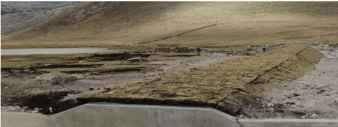
**Figura 27: Vista del espaldón de piedra de la cara húmeda del dique**
