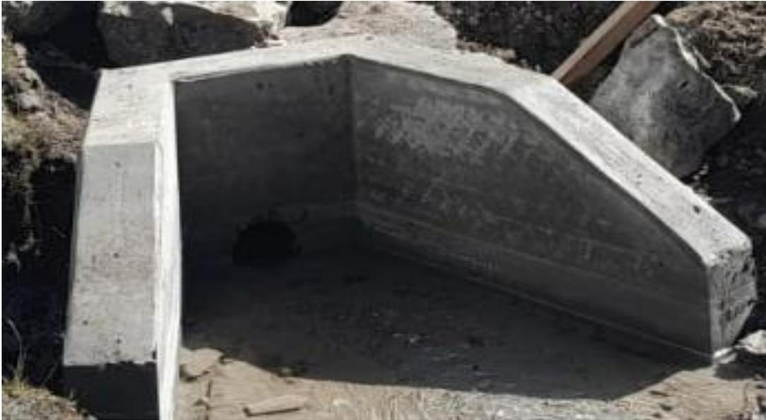
**Figura 29: Estructura de descarga**
