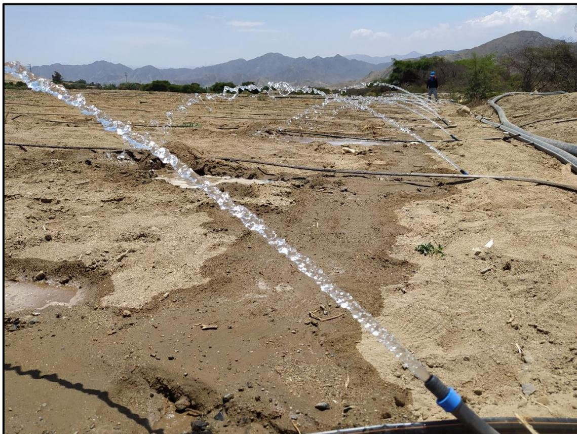
**Figura 17:** Purga de portarregantes antes de conectar laterales de riego.
