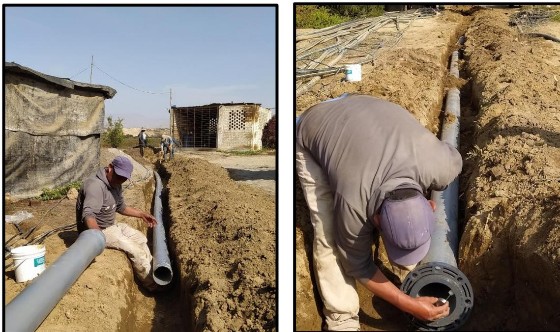
**Figura 16:** Instalación de tubería matriz por embone (izq.) y pegado (der.).
