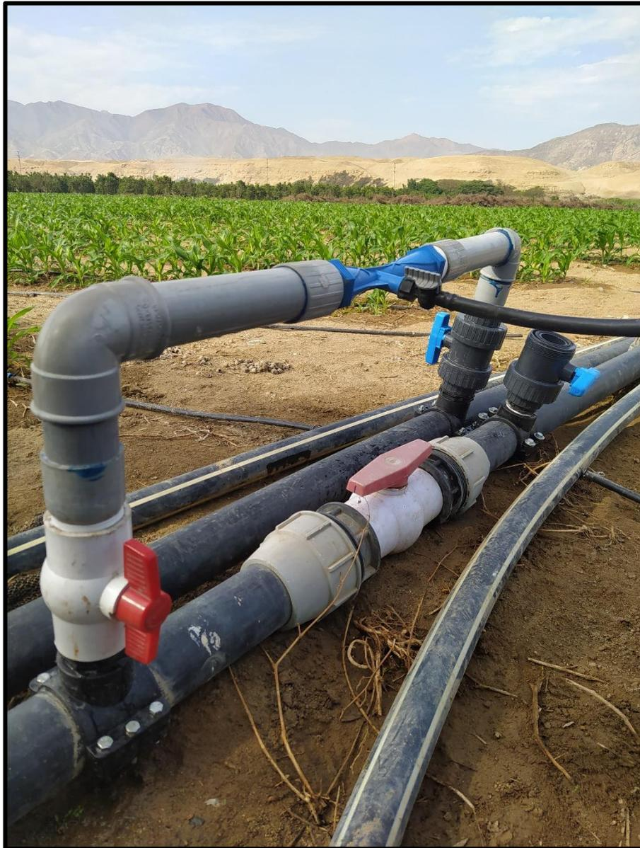
**Figura 25:** Vénturi de 2", instalado en bypass.
