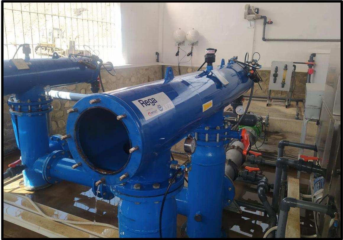
**Figura 26:** Filtros de retrolavado en un cabezal de riego.
