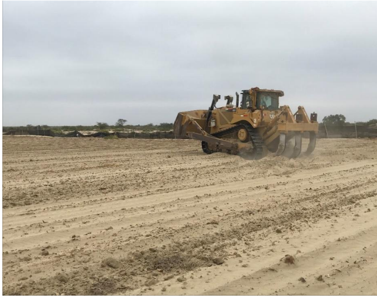
Figura 21: Tractor modelo D8T con ripper de 3 puntas realizando trabajos de subsolado
