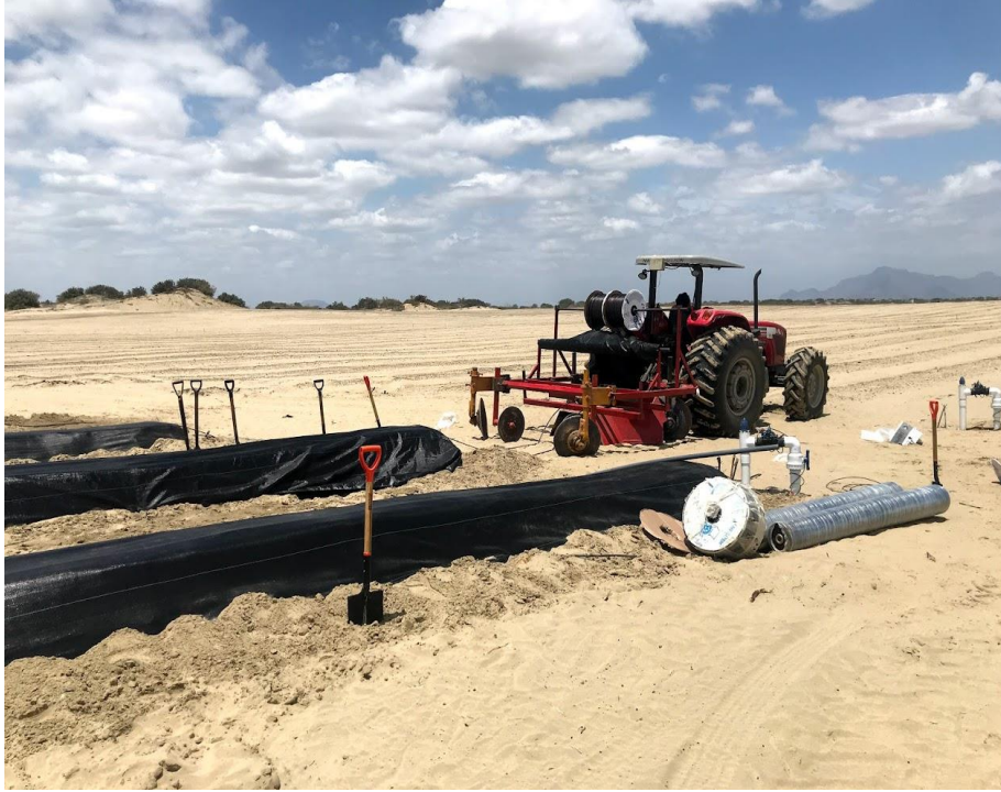
Figura 36: Colocación de mangueras de riego y manta cubre suelo.
