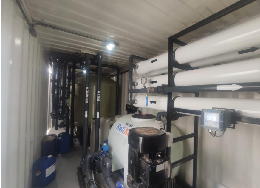
Figura 19: Planta de ósmosis inversa por dentro.
