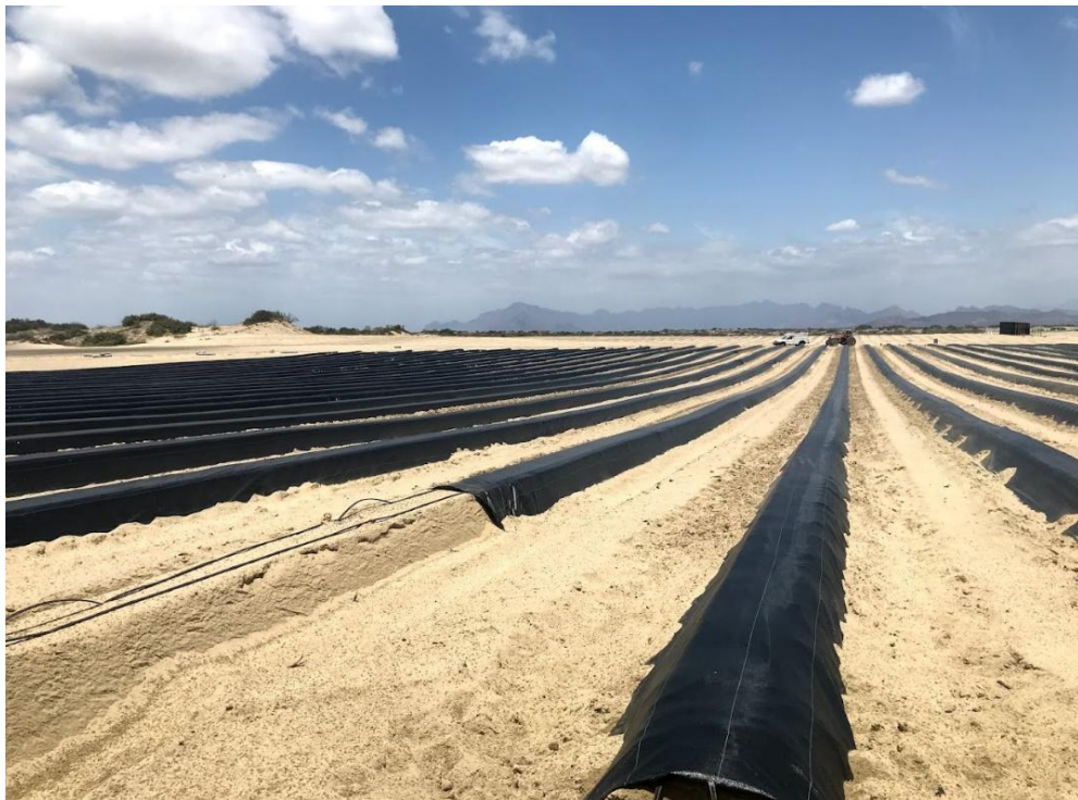
Figura 37: Camellón con la manta cubre suelo y mangueras ya colocadas.
