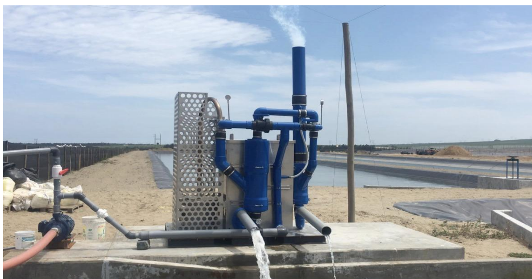
Figura 20: Quemador de azufre instalado en un campo
