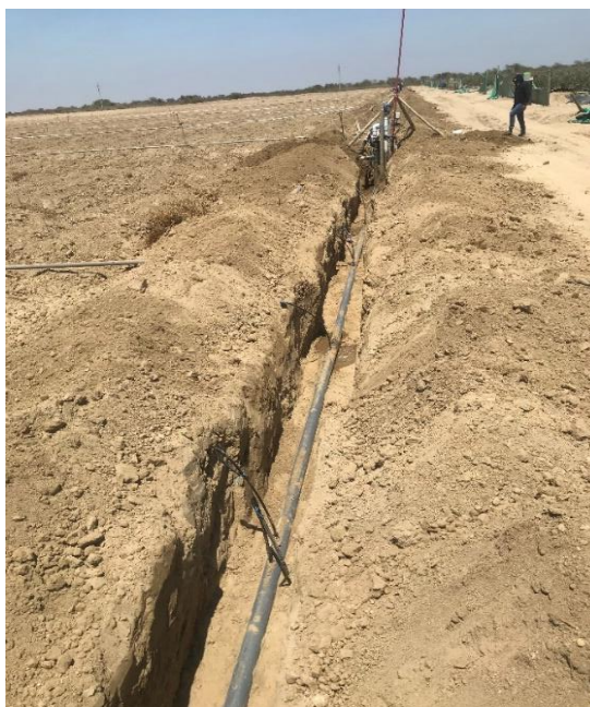
Figura 25: Excavación para descubrir tuberías laterales de riego.
