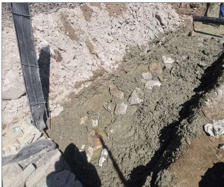
*Figura 27: Junta de Water Stop ubicado en base de cimentación del dique. Tomado del reporte semanal de avance de obra, 2021, Construcción de captación de agua; en el(la) recarga hídrica para 12 unidades productoras de los sistemas de riego en el distrito de Huamanquiya, provincia Víctor Fajardo, departamento Ayacucho.*
