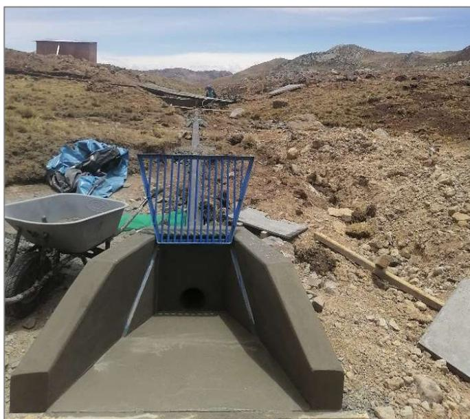
*Figura 43: Caja de toma de agua terminada. Tomado del reporte semanal de avance de obra, 2021, Construcción de captación de agua; en el(la) recarga hídrica para 12 unidades productoras de los sistemas de riego en el distrito de Huamanquiya, provincia Víctor Fajardo, departamento Ayacucho.*
