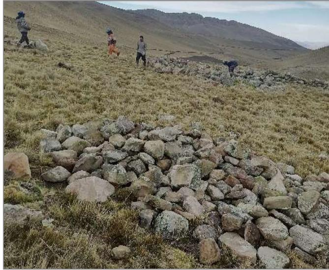
*Figura 28: Acopio de piedras medianas para el vaciado de concreto del dique. Tomado del reporte semanal de avance de obra, 2021, Construcción de captación de agua; en el(la) recarga hídrica para 12 unidades productoras de los sistemas de riego en el distrito de Huamanquiquia, provincia Víctor Fajardo, departamento Ayacucho.*
