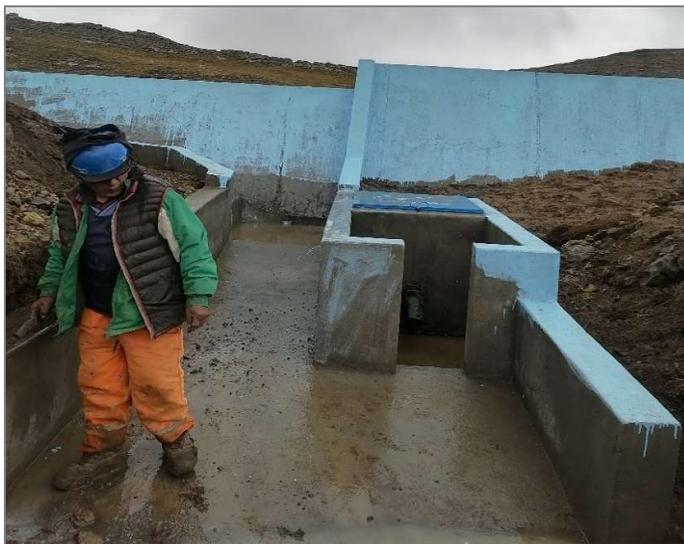
*Figura 37: Losa terminada correspondiente a la poza de disipación. Tomado del reporte semanal de avance de obra, 2021, Construcción de captación de agua; en el(la) recarga hídrica para 12 unidades productoras de los sistemas de riego en el distrito de Huamanquiya, provincia Víctor Fajardo, departamento Ayacucho.*
