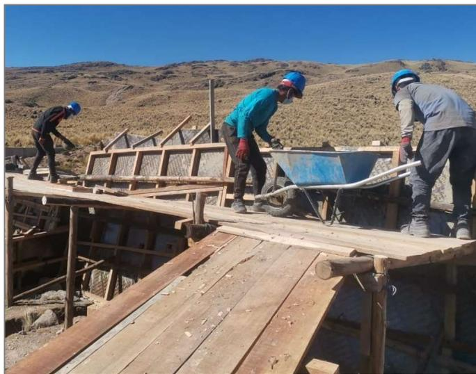
*Figura 34: Vaciado de concreto en tramo 4. Tomado del reporte semanal de avance de obra, 2021, Construcción de captación de agua; en el(la) recarga hídrica para 12 unidades productoras de los sistemas de riego en el distrito de Huamanquiya, provincia Víctor Fajardo, departamento Ayacucho.*
