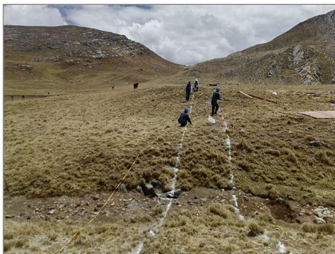
*Figura 22: Trazado con yeso el ancho de la base del dique. Tomado del reporte semanal de avance de obra, 2021, Construcción de captación de agua; en el(la) recarga hídrica para 12 unidades productoras de los sistemas de riego en el distrito de Huamanquiua, provincia Víctor Fajardo, departamento Ayacucho.*
