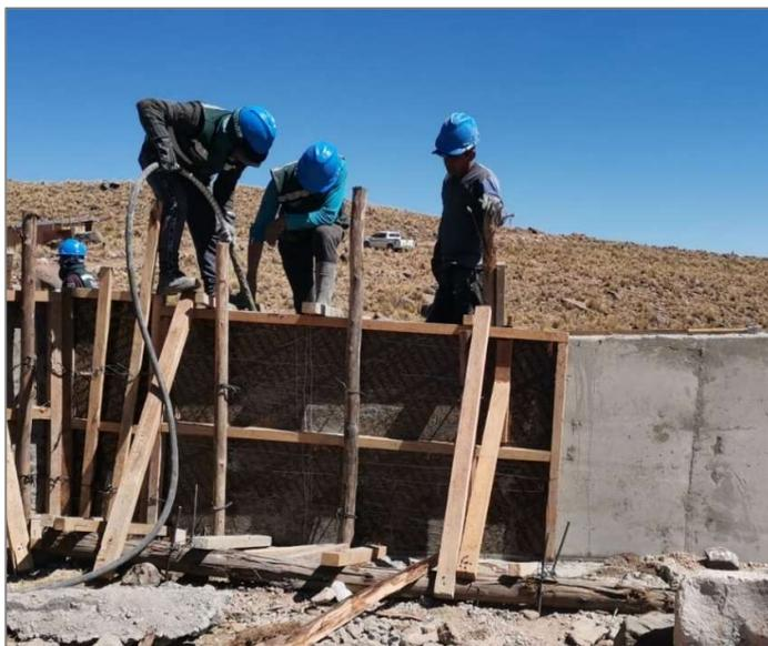
*Figura 31: Vibrado del concreto en el vaciado. Tomado del reporte semanal de avance de obra, 2021, Construcción de captación de agua; en el(la) recarga hídrica para 12 unidades productoras de los sistemas de riego en el distrito de Huamanquiya, provincia Víctor Fajardo, departamento Ayacucho.*
