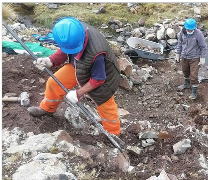
Figura 25: Excavación de roca suelta con herramientas manuales. Tomado del panel fotográfico, 2021, Informe N°01 del Técnico en Seguridad y Salud.
