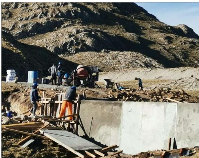
*Figura 32: Desencofrado del tramo 6. Tomado del reporte semanal de avance de obra, 2021, Construcción de captación de agua; en el(la) recarga hídrica para 12 unidades productoras de los sistemas de riego en el distrito de Huamanquiya, provincia Víctor Fajardo, departamento Ayacucho.*
