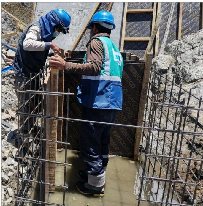
*Figura 40: Encofrado para la caja de descarga. Tomado del panel fotográfico, 2021, Informe N°02 del Técnico en Seguridad y Salud.*
