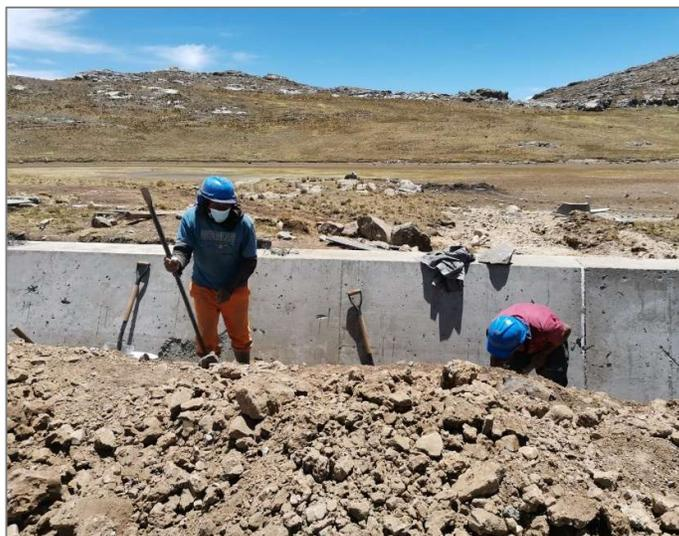
*Figura 45: Restauración morfológica en la zona cercana al dique. Tomado del panel fotográfico, 2021, Informe N°02 del Técnico en Seguridad y Salud.*
