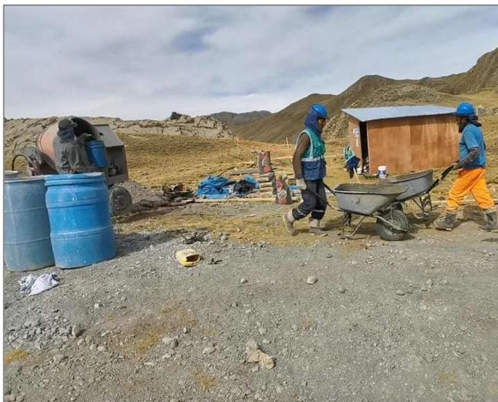
*Figura 30: Preparado y traslado de mezcla de concreto  $F'c=210 \text{ Kg/cm}^2$ . Tomado del panel fotográfico, 2021, Informe N°01 del Técnico en Seguridad y Salud.*
