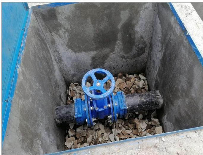
Figura 44: Válvula de control en estructura de descarga. Tomado del reporte semanal de avance de obra, 2021, *Construcción de captación de agua; en el(la) recarga hídrica para 12 unidades productoras de los sistemas de riego en el distrito de Huamanquiya, provincia Víctor Fajardo, departamento Ayacucho.*
