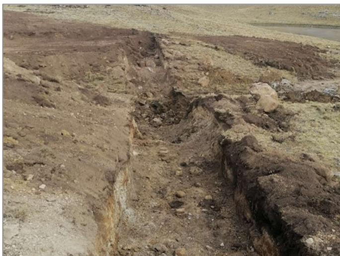
*Figura 24: Excavación de material suelto en el eje del dique. Tomado del reporte semanal de avance de obra, 2021, Construcción de captación de agua; en el(la) recarga hídrica para 12 unidades productoras de los sistemas de riego en el distrito de Huamanquiua, provincia Víctor Fajardo, departamento Ayacucho.*
