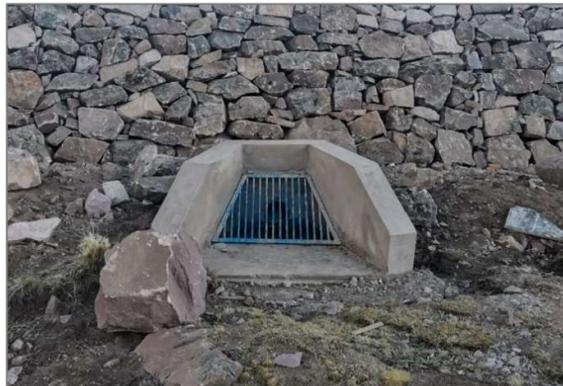
*Figura 4: Caja de toma terminada. Tomado de "Estructura de toma terminada" por la Unidad Ejecutora "Fondo Sierra Azul", 2020, Expediente técnico de inversión "Construcción de captación de agua; en el(la) recarga hídrica para 12 unidades productoras de los sistemas de riego en el distrito de Huamanquiya, provincia Víctor Fajardo, departamento Ayacucho".*
