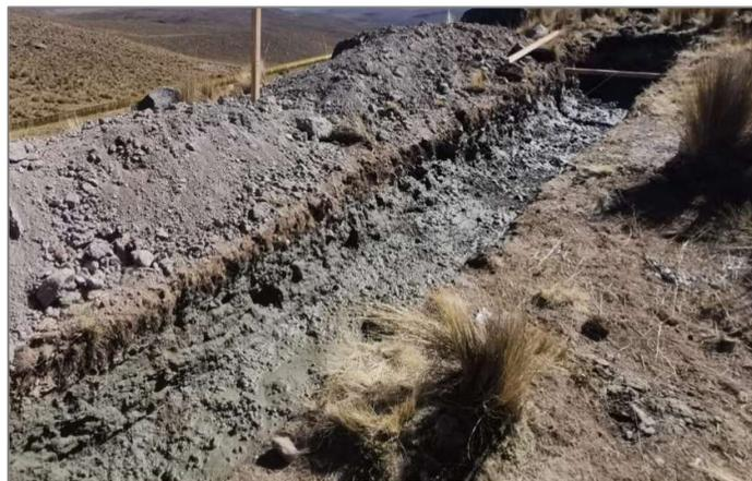
*Figura 26: Lechada de agua cemento en zanja excavada. Tomado del reporte semanal de avance de obra, 2021, Construcción de captación de agua; en el(la) recarga hídrica para 12 unidades productoras de los sistemas de riego en el distrito de Huamanquiya, provincia Víctor Fajardo, departamento Ayacucho.*
