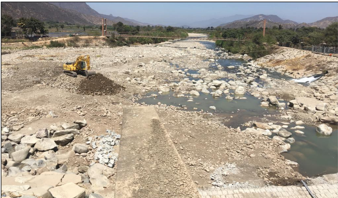
Figura 27: Vista aguas abajo de la bocatoma
