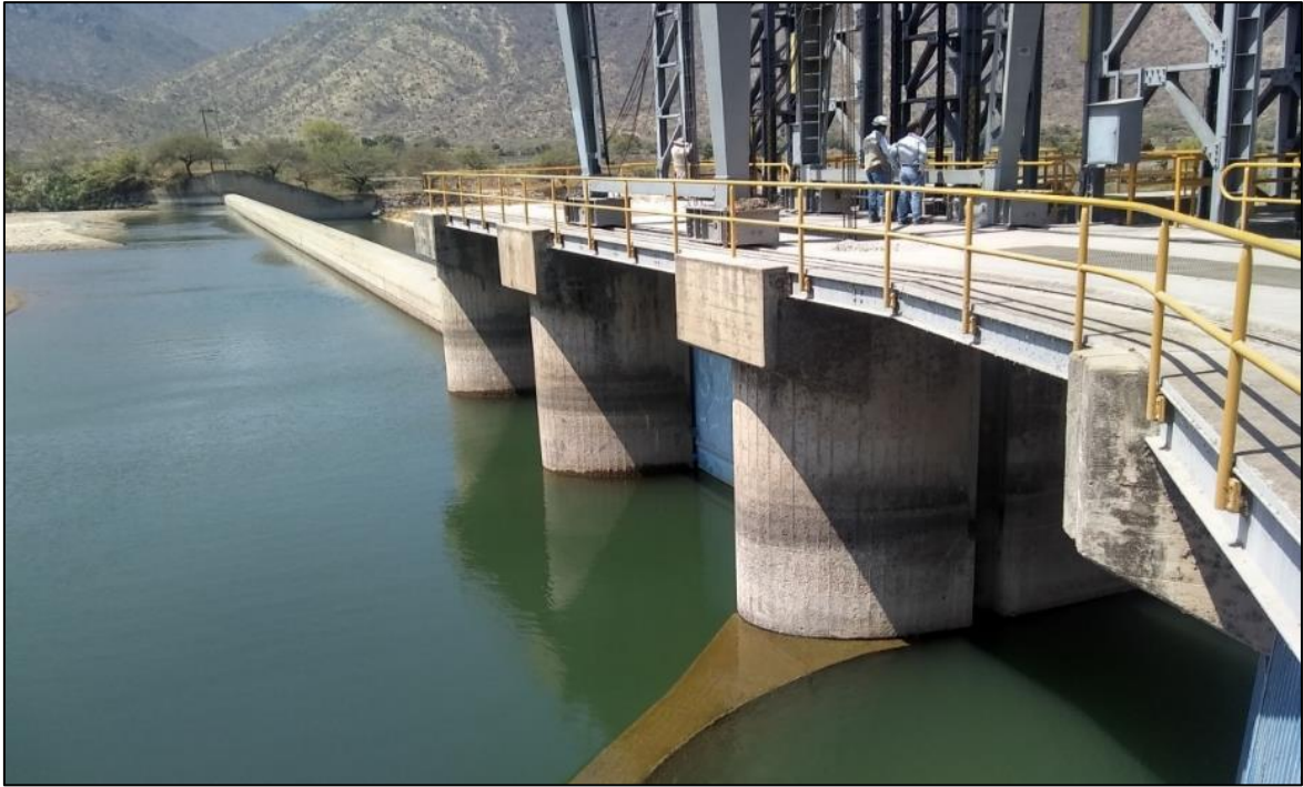
Figura 28: Compuertas en barrage móvil
