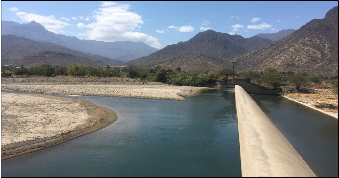
Figura 24: Vista de estribo izquierdo de bocatoma
