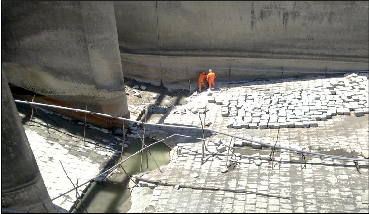
Figura 26: Vista de revestimiento de poza disipadora en barraje móvil.
