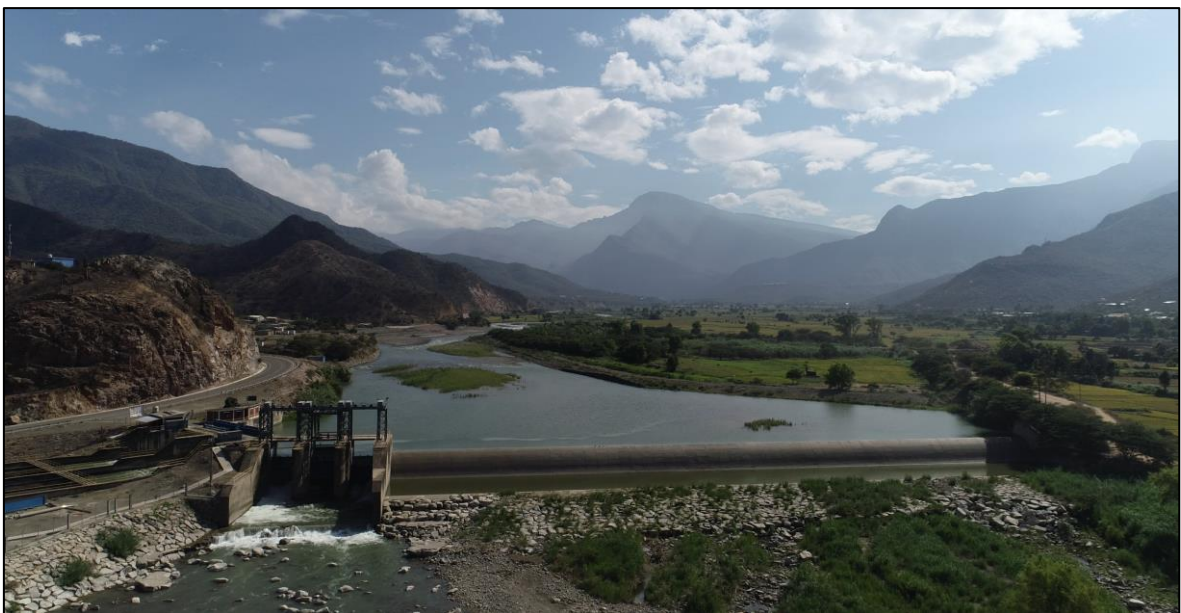
Figura 23: Vista frontal de la bocatoma Raca Rumi.
