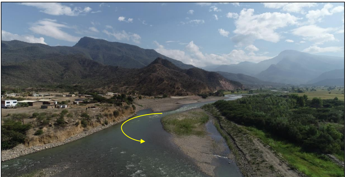
Figura 16: Zona de erosión quebrada Cerro Blanco.
