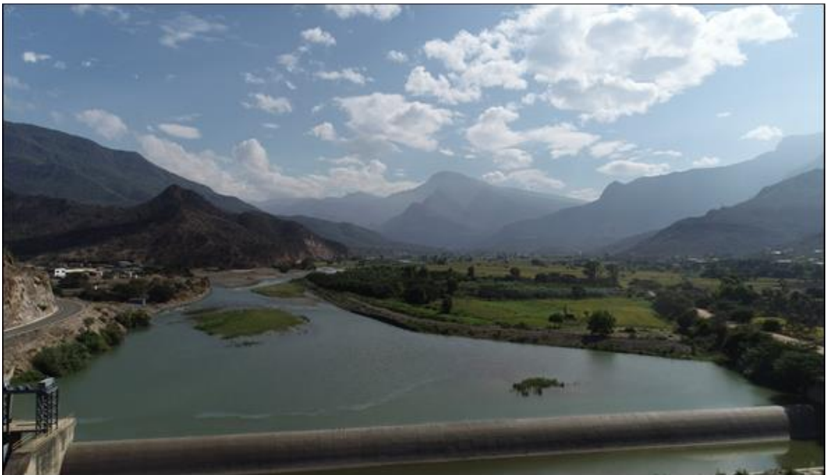
Figura 14: Reducción de cauce y sedimentación por acción antrópica en barrage fijo.
