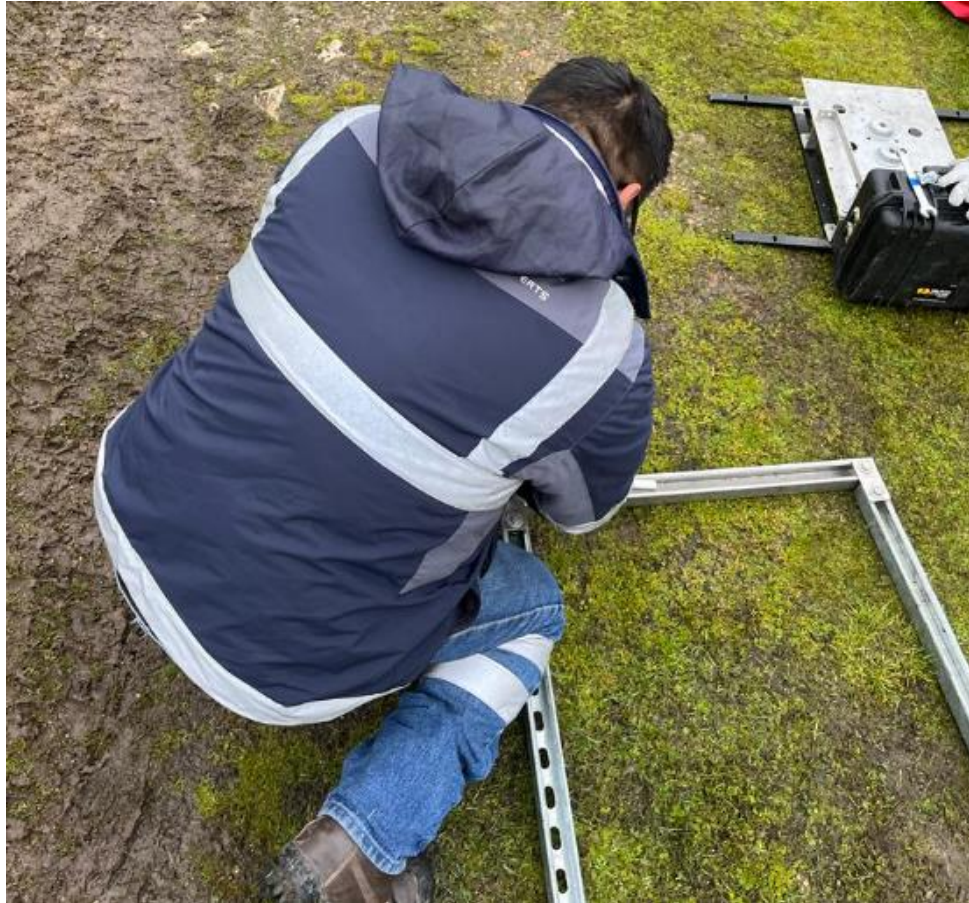
Figura 40: Armado de la estructura soporte de los sensores del bote
