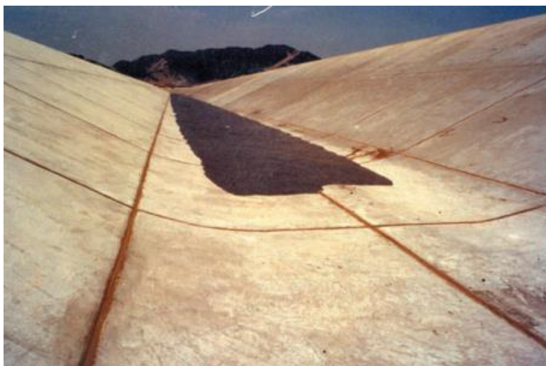
Figura 12: Agua del río Santa discurre por primera vez por el canal madre, el 20 de julio de 1990.
