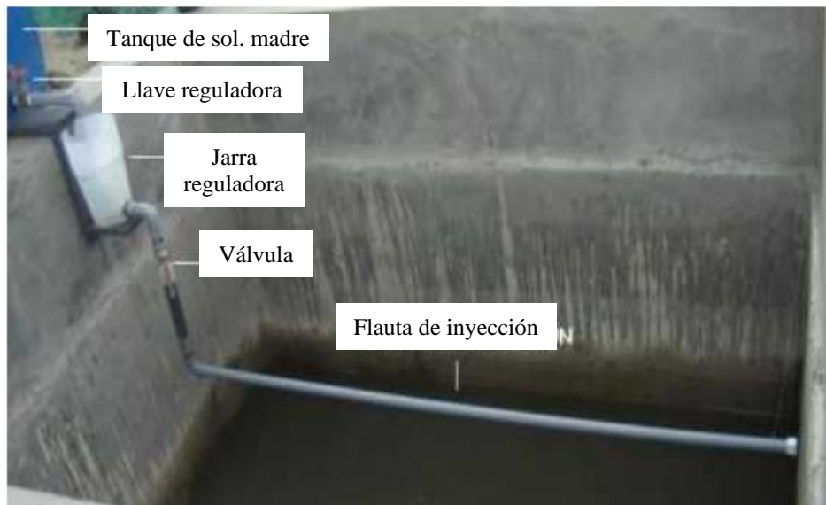
Figura 32: Sistema de dosificación.
