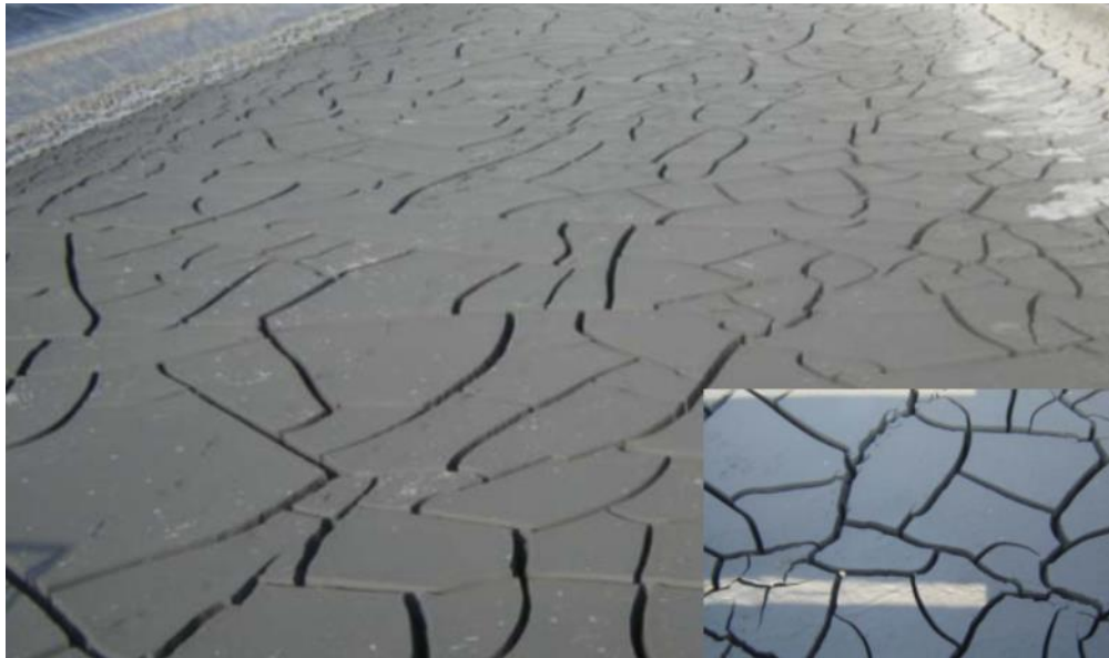
Figura 20: Sedimentador colapsado por exceso de SS. El lodo resultante forma capas que requieren ser eliminadas.
