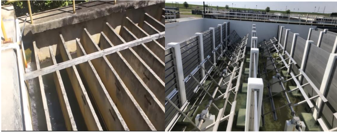
Figura 6: Flocculadores del tipo hidráulico y tipo mecánico.
