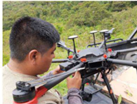
d) Montaje de baterías
