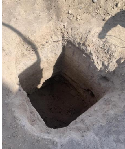
Figura 62: Zanja de poste de RTU
