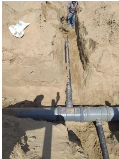
Figura 61: Zanja de tuberías
