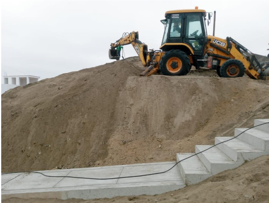
Figura 37: Conformación de lomas
