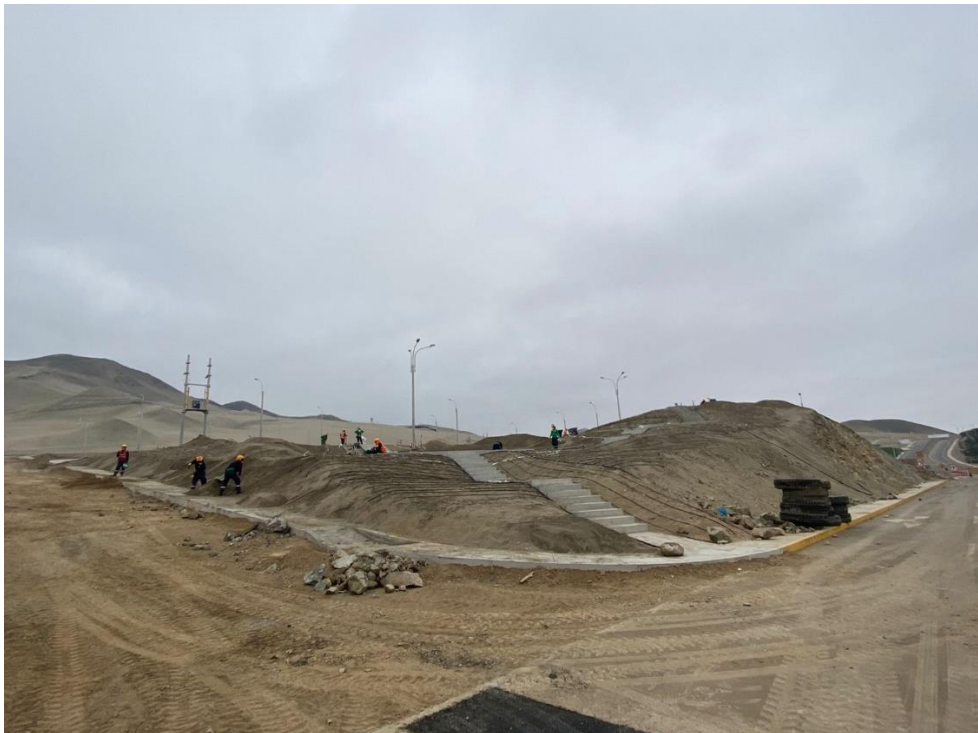
Figura 36: Preparación de terreno de parque distrital.
