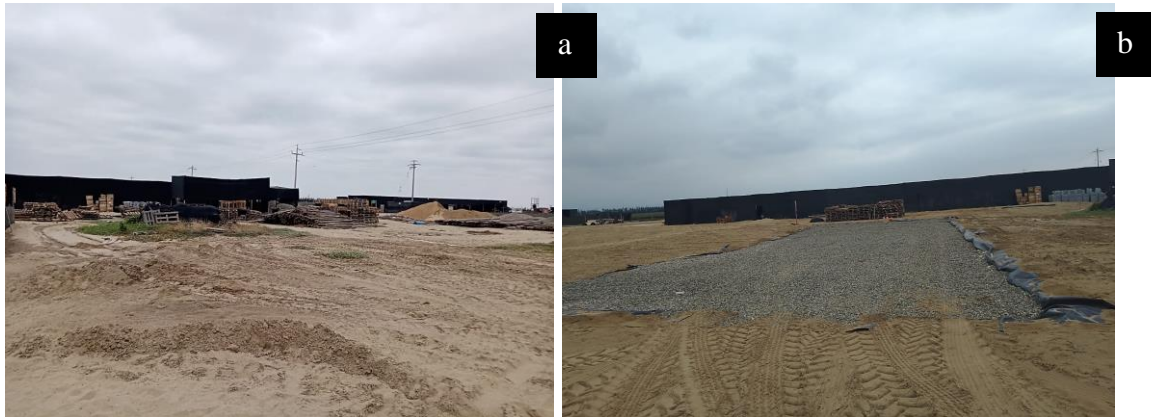
Figura 5: Zona de lavado de maquinaria en el Fundo
