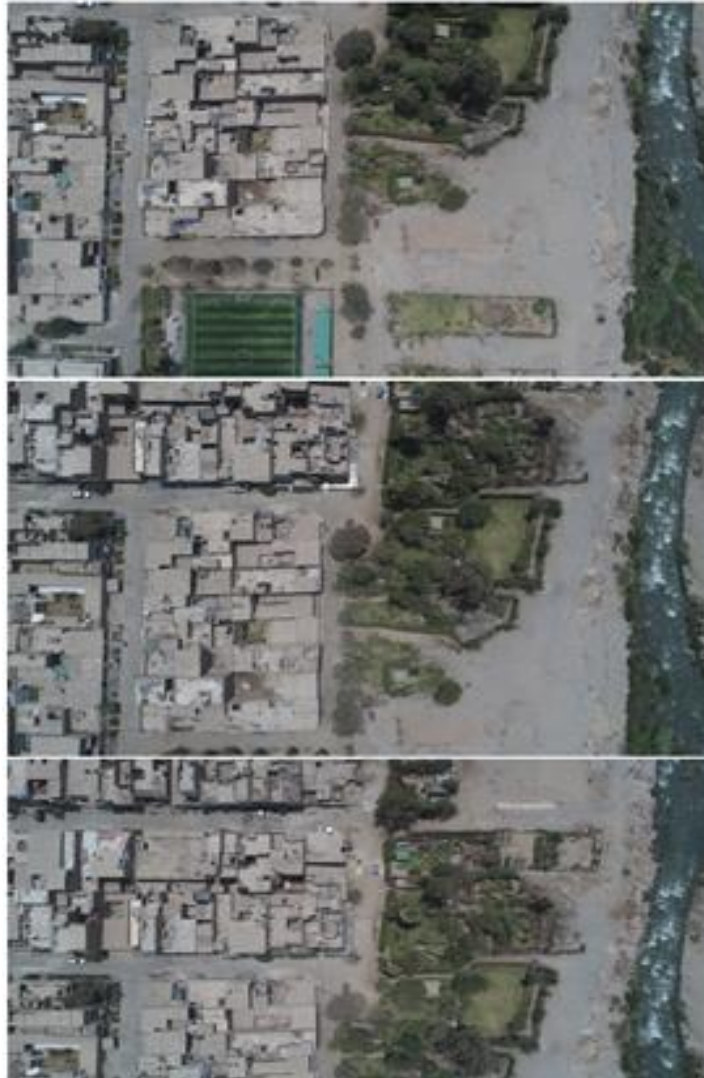
Figura 16: Levantamiento Topográfico con Dron Phantom
