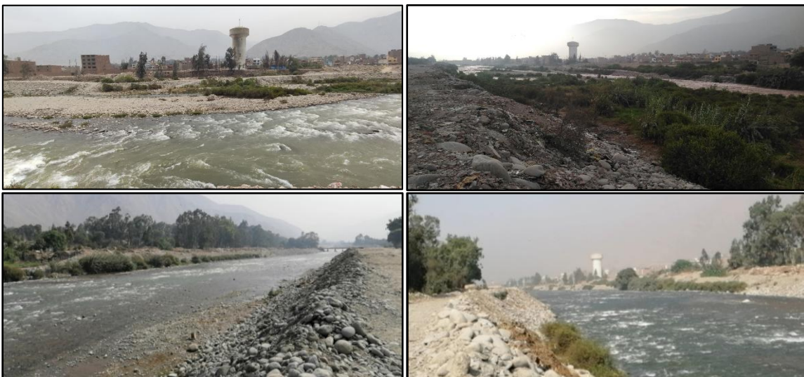
Figura 15: Inspección de campo
