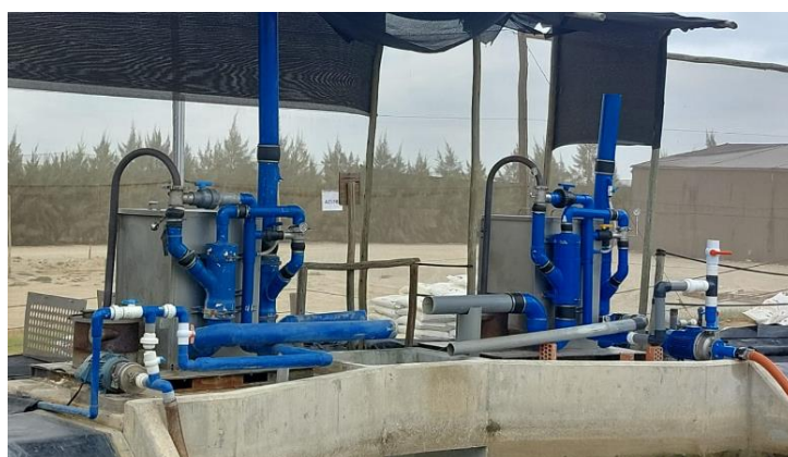
Figura 13. Quemadores de azufre usados para la acidificación de agua en reservorios.
