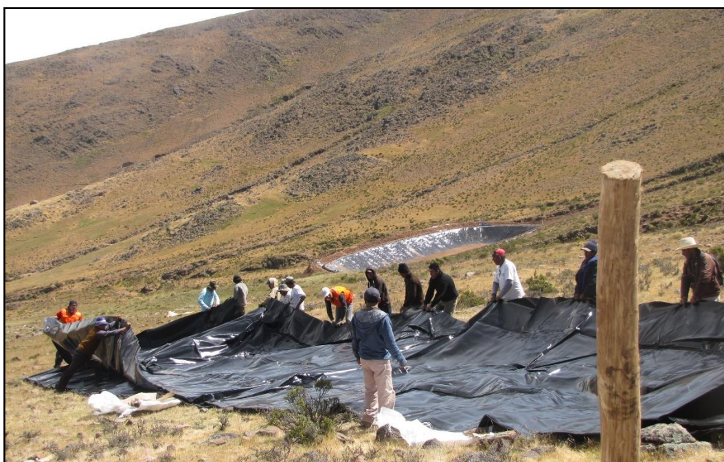
Proceso constructivo de reservorio de geomembrana
