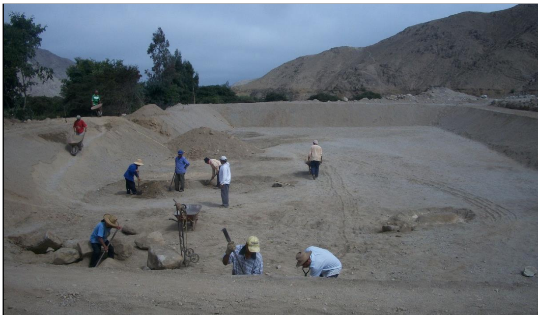
Construcción de reservorio de geomembrana
