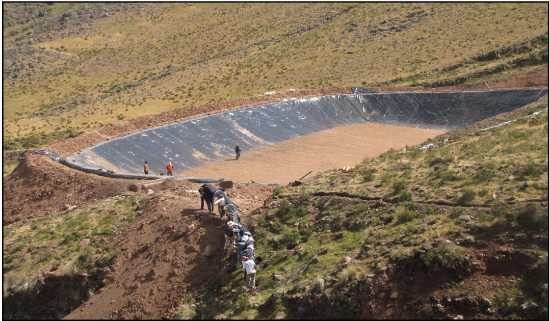
Revestimiento de reservorio con geomembrana de PVC
