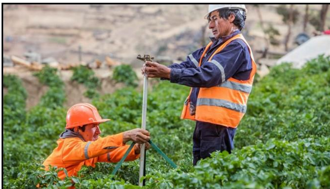
Instalación sistema de riego por aspersión – Cultivo de papa
