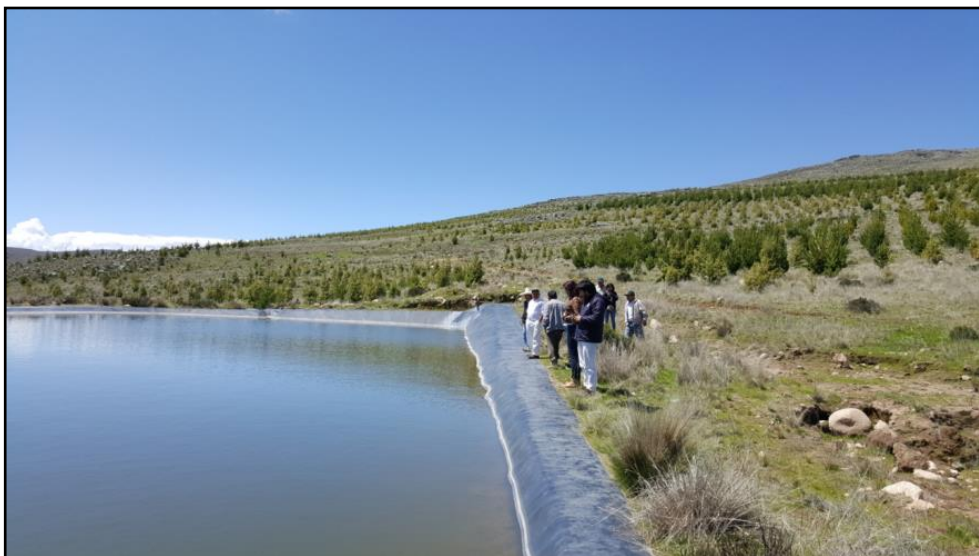
Figura 17: Reservorios de geomembrana para riego complementario de plantaciones
