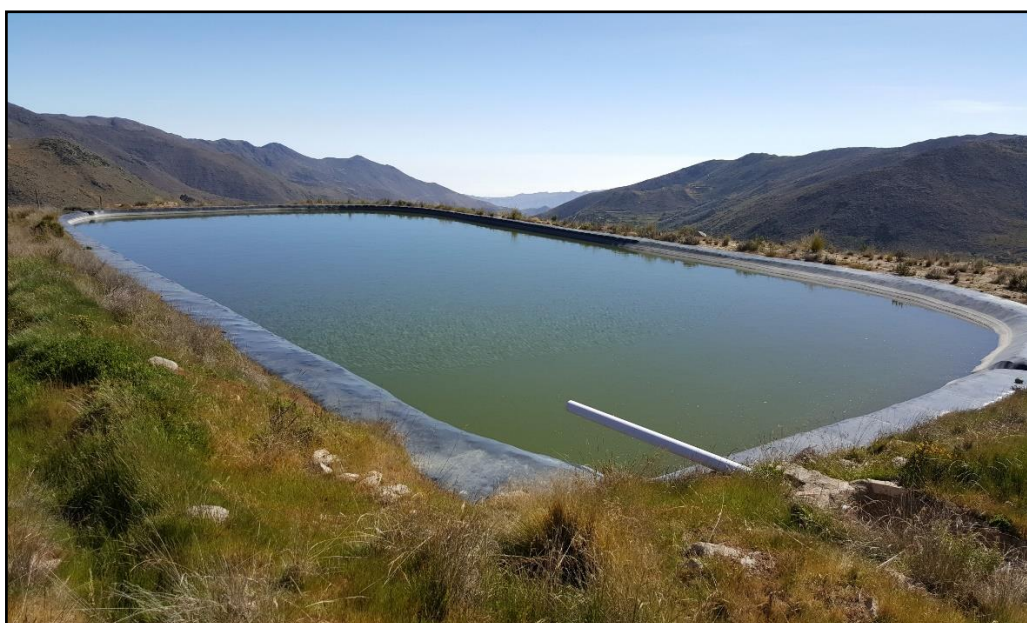
Figura 13: Reservorio de Almacenamiento de Agua en cuenca alta de Chavín
