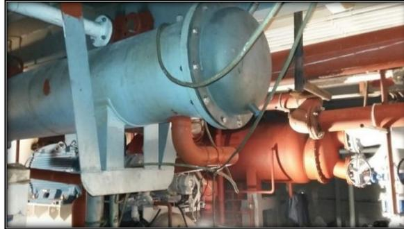
*Nota:* Foto de sala de máquinas de proa de la embarcación Huacho Cinco, donde figura el condensador del sistema de frío.
