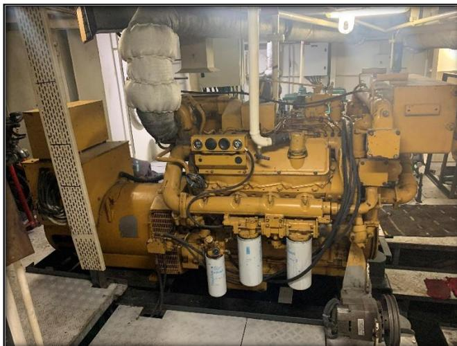
*Nota:* Foto del Grupo eléctrico 3408 instalado en la embarcación Huacho cinco.
