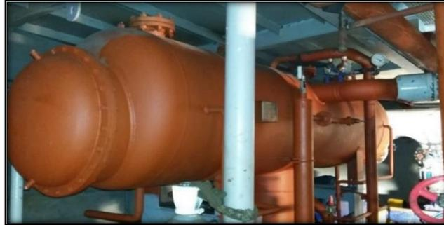
*Nota:* Foto de sala de máquinas de proa de la embarcación Huacho Cinco, donde figura el chiller del sistema de frío.
