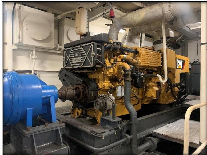
*Nota:* Foto del Grupo electrónico C18 instalado en la embarcación Huacho cinco.
