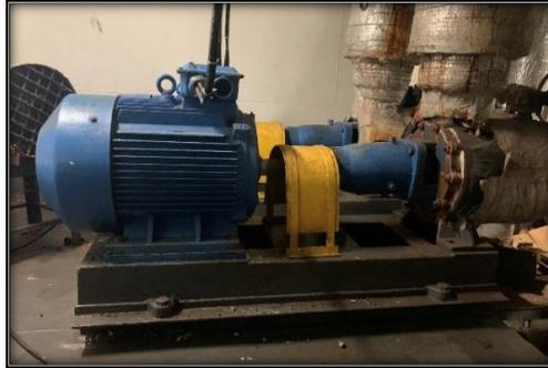
*Nota:* Foto de sala de máquinas de proa de la embarcación Huacho Cinco, donde figura la bomba de cloruro de calcio del sistema de frío
