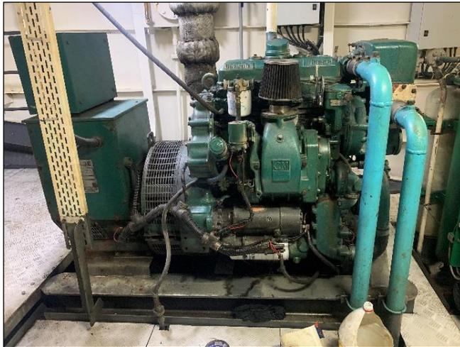
*Nota:* Foto del Grupo electrógeno 371 instalado en la embarcación Huacho cinco.
