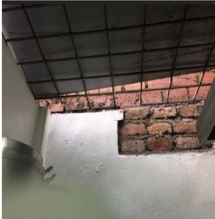
Figura 15: Abertura en el área de la cocina
