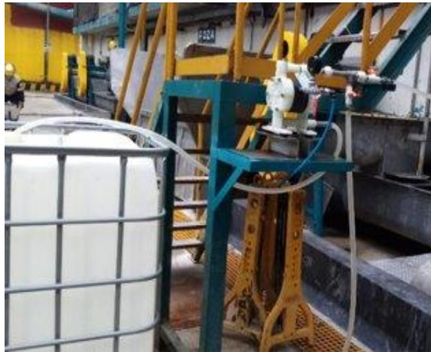
**Figura N°3 : Bomba dosificadora**
