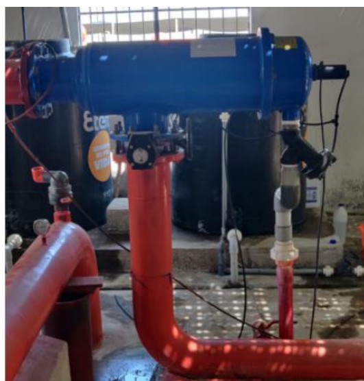
Figura 8. Cabezal de filtrado YAMMIT
