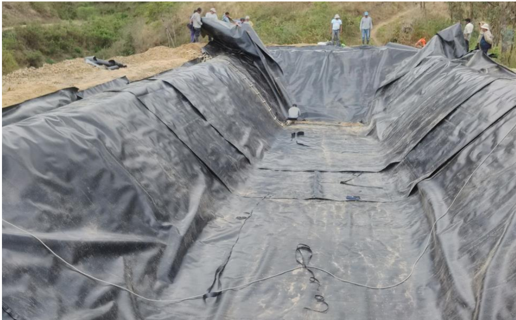
Figura 10: Tendido y termosellado de geomembrana.
