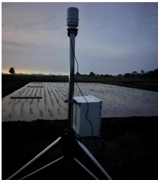
Figura 12: Instalación de la estación meteorológica automática portátil ATMOS 41
