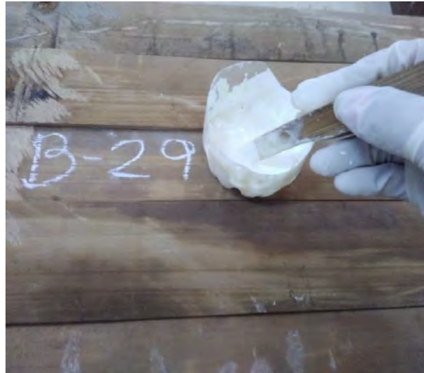
Figura 23: Aplicación de adhesivo en latas de Dendrocalamus asper
