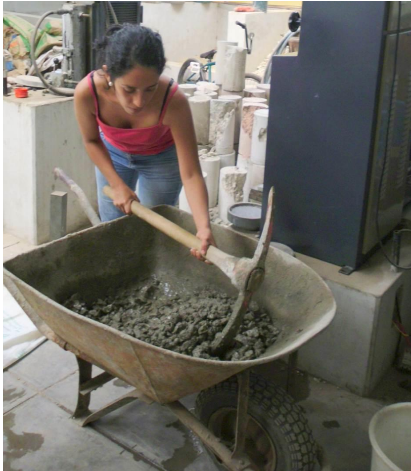
Figura N° 7: Preparación de concreto en carretilla
